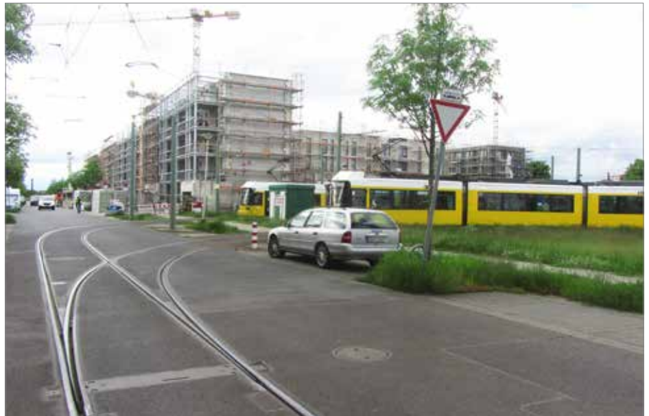
Die letzten Tage der Wendeschleife in Adlershof. Minimale Wendezeit hier: eine Minute. In einem Stumpfgleis mit Zweirichtungs-Wagen wären es vier Minuten gewesen. Statt des sinnvollen und wartungsarmen Blechschildes im Vordergrund hat die neue Strecke nach Schönevide leider eine teure Ampel erhalten, die unnötige Wartezeiten für die Straßenbahn und für die Autos verursacht!
