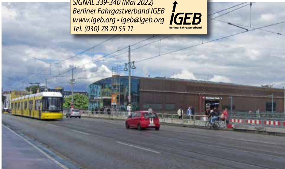
Das Umsteigen zum S-Bahnhof Warschauer Straße bleibt leider weiterhin mangelhaft. Die Fortführung des Fußgängerstegs auf die Nordseite des Bahngrabens wäre ein erster Schritt zur Entlastung der Bürgersteige auf der Straßenbrücke.
