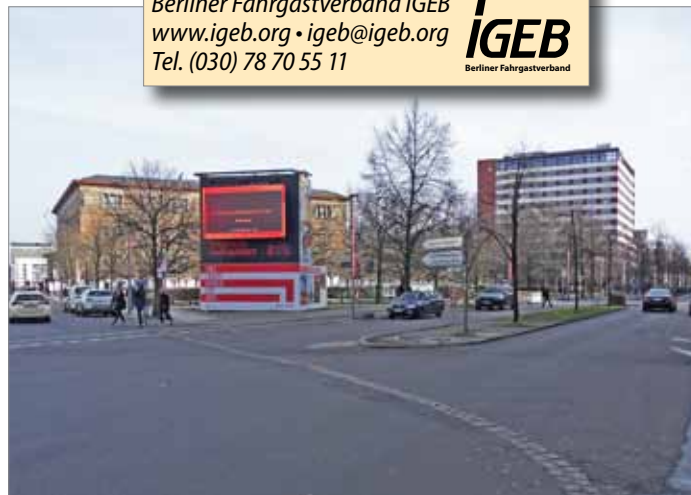
Unter der Stresemannstraße liegt der Bestandstunnel der Nordsüd-S-Bahn. Die S6 fädelt Höhe Niederkirchnerstraße aus und führt im Bogen unter der Freifläche, hinter dem Gropiusbau vorbei, zur Kochstraße. Fotos: Tom Gerlich
