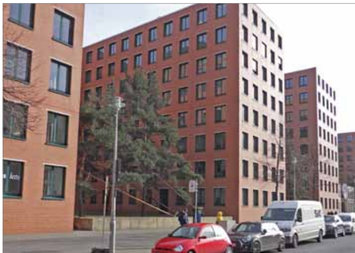
Dieses Gebäude (Block 2) an der Gabriele-Tergit-Promenade blockiert mit seinem Fundament Teile der S21-Vorleistung. Nur die beiden inneren Gleise am Potsdamer Platz können so in Richtung Gleisdreieck angebunden werden. Dadurch ist die Flexibilität eingeschränkt.
