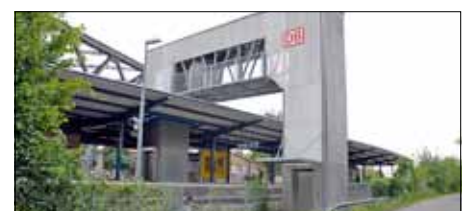
Betriebsbahnhof Rummelsburg (DB) hat eine Sonderbauform eines Aufzuges, nämlich einen „PeopleMover“. Obwohl der Aufzug eher seitlich fährt und die Tasten zum Türenöffnen vom Symbol her logischer zum Starten des Aufzuges wären, muss man den Hoch-/Runterknopf zum Start betätigen.
