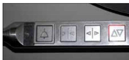
Betriebsbahnhof Rummelsburg (DB) hat eine Sonderbauform eines Aufzuges, nämlich einen „PeopleMover“. Obwohl der Aufzug eher seitlich fährt und die Tasten zum Türenöffnen vom Symbol her logischer zum Starten des Aufzuges wären, muss man den Hoch-/Runterknopf zum Start betätigen.
