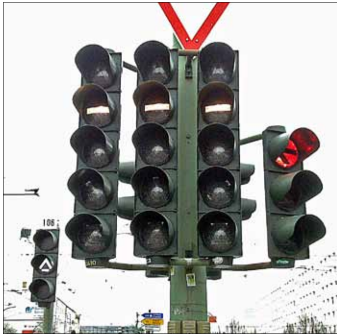
Lichtsignalanlage für Straßenbahnen Landsberger Allee Ecke Petersburger Straße. Der waagerechte Balken bedeutet „Halt“ – ein Signalbild, das die Straßenbahn allzu oft sieht.
