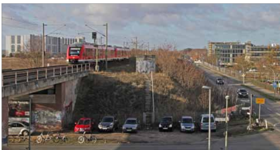
Die Stadt-Umland-Korridoruntersuchung sieht die Zusammenlegung der beiden nahen Halte Albrechtshof und Seegefeld vor. Kann man machen, muss man aber nicht. Falls doch, könnte man hier (siehe oben) den neuen S-Bahnsteig „Albrechtsseeghoffeld“ nebst Brücke errichten, bevor der Regionalzughalt Albrechtshof stadtauswärts entfällt.
