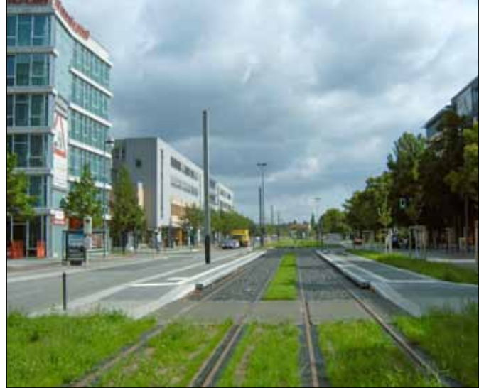
Im Frühjahr 2011 wird die Straßenbahnneubaustrecke in die Wissenschaftsstadt Adlershof endlich fertig. Dann muss mithilfe der einbehaltenen S-Bahn-Gelder sofort mit der Verlängerung zum Bahnhof Schöneweide begonnen werden. Foto: Frank Lammers
