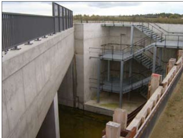
Bereits fertiggestellter westlicher Tunnelmund für vier Gleise nahe Selchow. Foto: F. Müller, Oktober 2007
