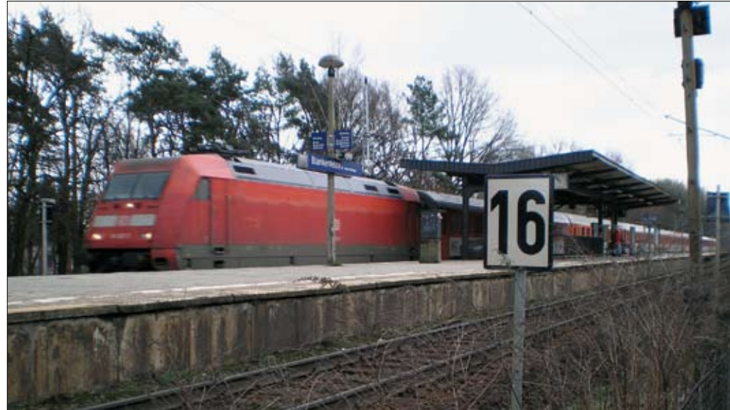
Infrastrukturmängel lassen derzeit leider nur auf wenigen Abschnitten der Strecke Berlin—Dresden die Höchstgeschwindigkeit von 160 km/h zu. Die Fahrzeiten der Eurocity-Züge zwischen Berlin und Prag sind deshalb unattraktiv lang.
