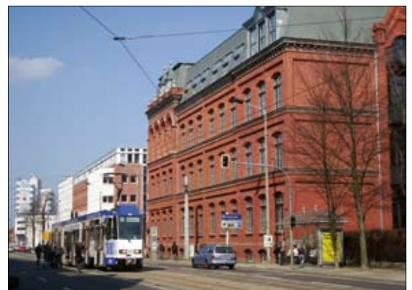
Die Straßenbahn in der Bahnhofstraße. Eine Umstellung auf Dieselsebusse würde die Luftqualität hier noch weiter verschlechtern.
