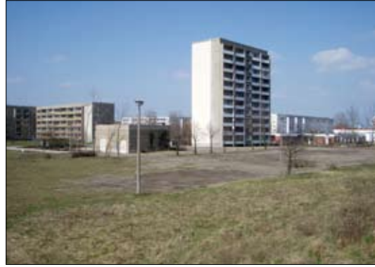
Schrumpfung in Cottbus-Sachsendorf. Der Lichtmast auf der Wiese steht noch, das Haus und die Straße daneben sind bereits abgerissen. Welche Auswirkungen hat das auf den Verkehr?
