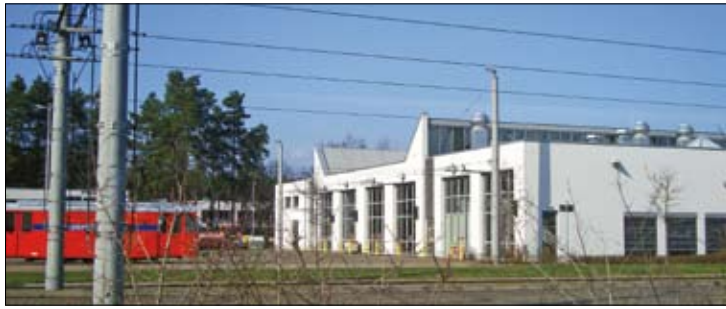
Vor wenigen Jahren ist kräftig in die Infrastruktur der Cottbuser Straßenbahn investiert worden, so wie hier in den neuen Betriebshof in Neu Schmellwitz. Bei einer Abschaffung der Straßenbahn sind Fördermittelrückzahlungen zu erwarten.
